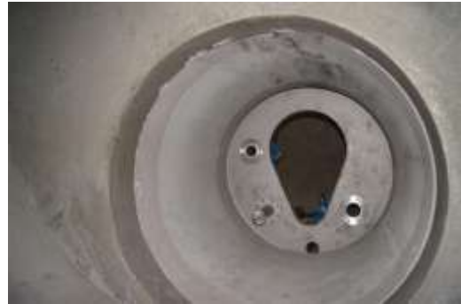
Verbindungsstück aus der Sicht der Wasserkammer
