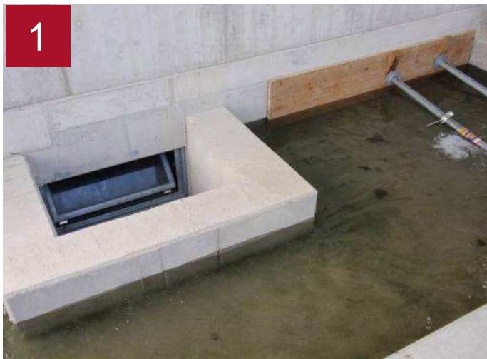
1 Kellerfenster links mit PrevFix System, rechts herkömmlich mit Schalungsplatte
