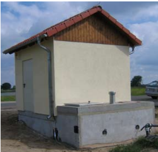
Biofilter im Vorschacht integriert
