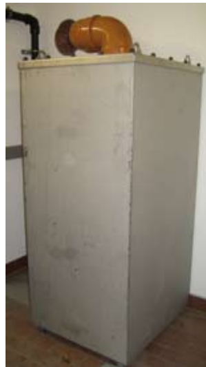
Biofilter für Aufstellung im Betriebsraum
