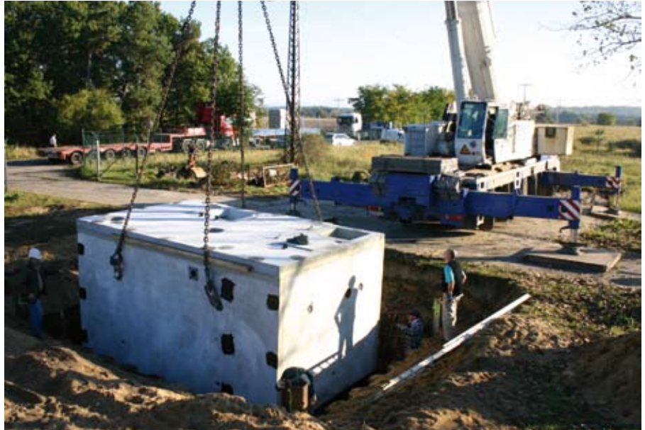
Setzen einer schlüsselfertigen Pumpstation
