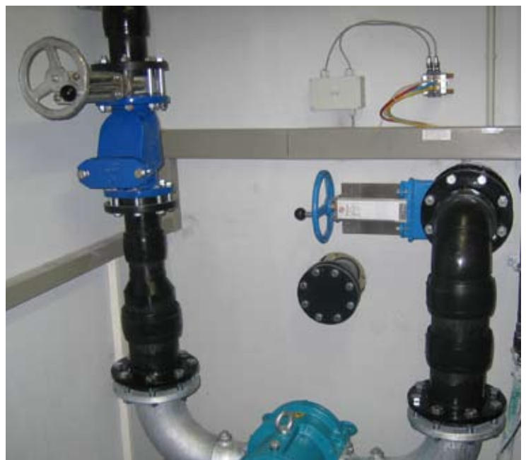
Nachrüstung Drehkolbenpumpe zur Erhöhung der Förderleistung
